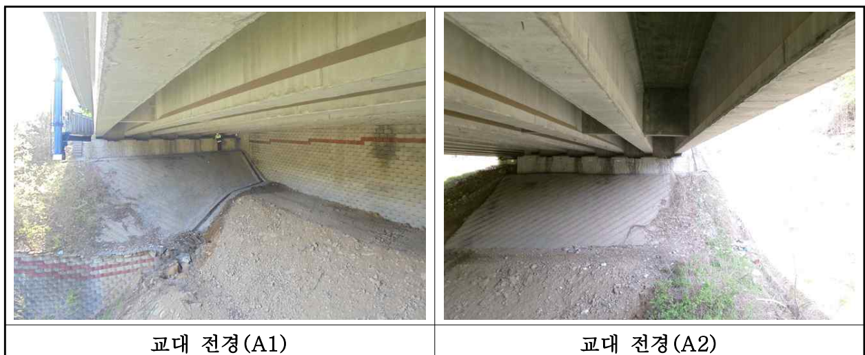
【사진 1.3.8】 교대 전경
