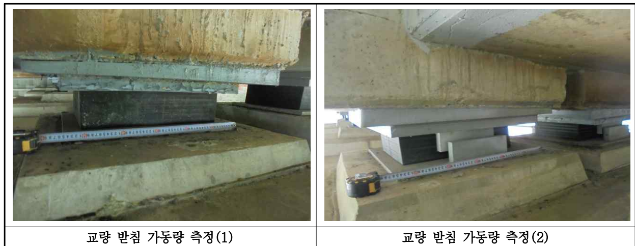
【사진 1.3.15】 교량받침 이동량 측정
