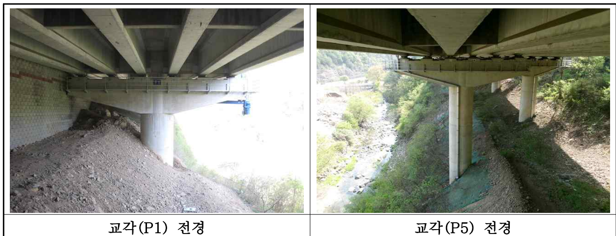
【사진 1.3.10】 교각 전경
